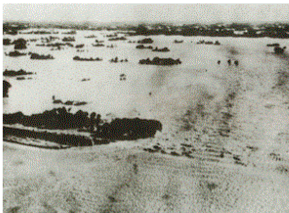
9月16日午前零時20分、埼玉県東村(大利根町/現:加須市)の利根川右岸堤防が決壊。濁流はいよいよ魔の手を広げ始めた(9月17日 栗橋町上空より) 出典:「報道写真集 カスリーン台風」(1997年) 埼玉新聞社出版局
