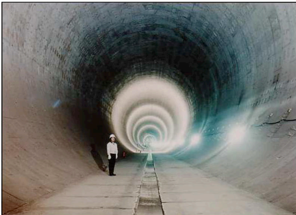
神田川・環状七号線地下調節池
