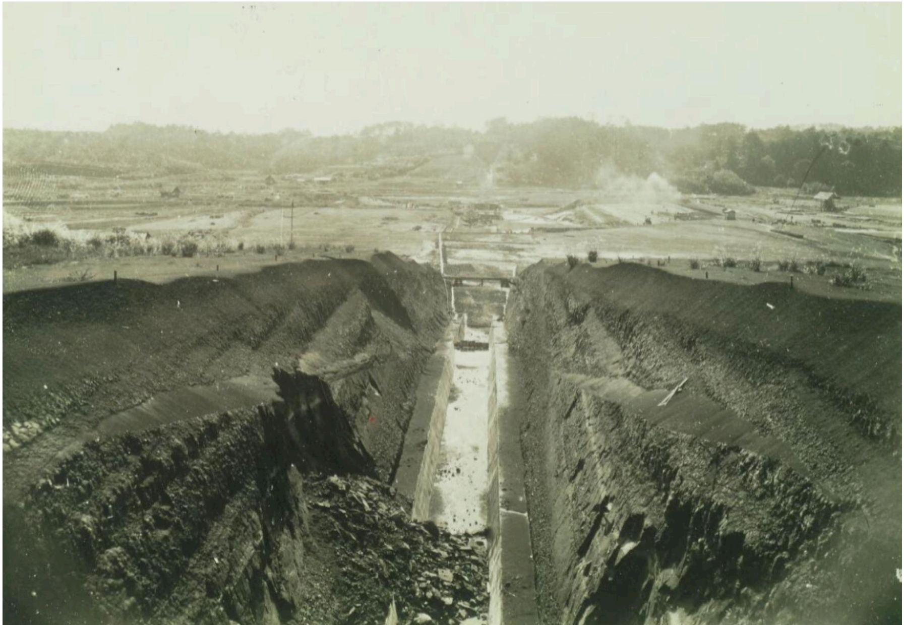
村山貯水池：堰堤堤心部工事（東京都水道歴史館デジタルアーカイブ）
