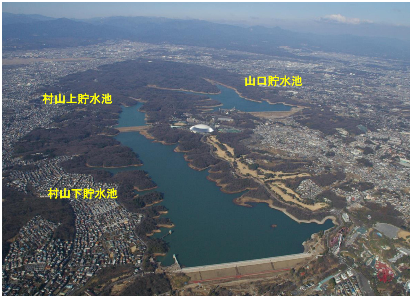
村山・山口貯水池の全景（東京都水道局）
